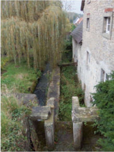
2014: Kanalisierte Berlebecke links; rechts: Drainage-Kanal unter den beiden Wasserrädern. Eine Achse ist noch zu erkennen.
