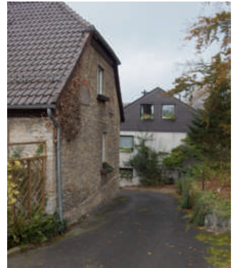
Ostfront des Mühlenwohnhauses, neues Wohnhaus auf den Fundamenten des Sägewerkes
