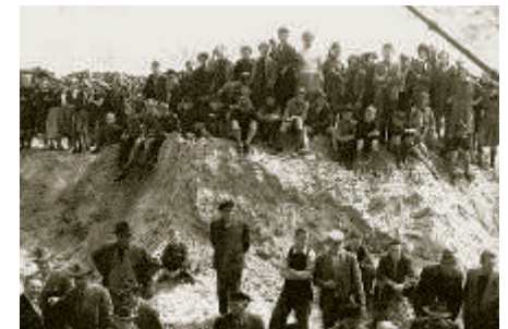
Bau des Sporthäuschens mit Duschanlagen
