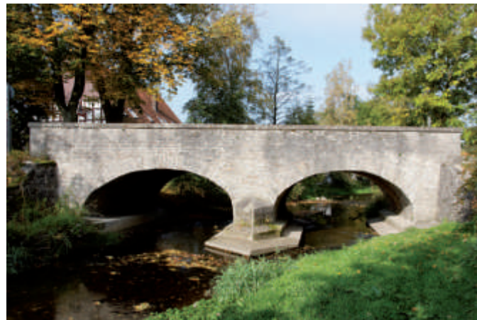
Die Brücke über die Wiembecke
