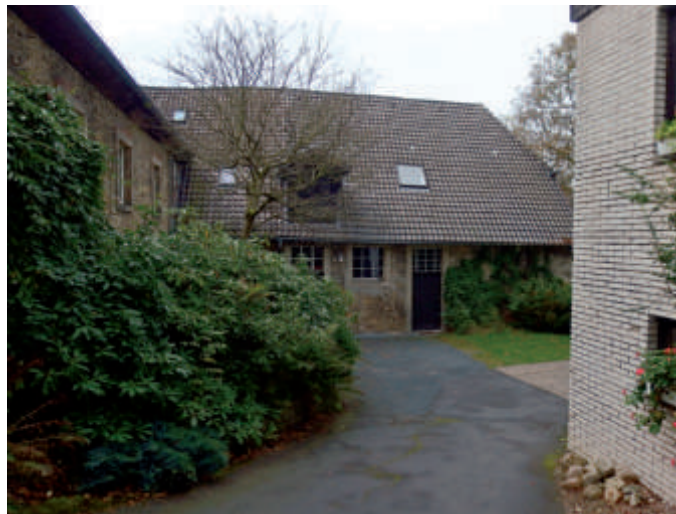
Links: Wohnhaus mit früherem Scheunenteil. Rechts: Wohnhaus auf dem Fundament der Sägemühle. Hinten: Betriebsgebäude mit zuletzt: Rechts Kuhstall, Mitte Pferdestall. Große Hauptmühlenhalle im linken Winkel, etwa 1,5 m tiefer als die Ställe
