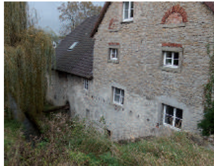
Hauptwirtschaftsteil der Kammermühle mit Rest von Wasserradachse
