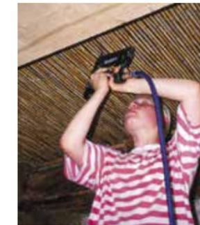
Anne Fasselt tackert Schilfrohmatten an die Decke als Unterkonstruktion für den Putz
