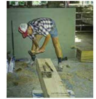
Nach dem Zuschnitt im Sägewerk bearbeitet Wilhelm Möllbrok den Deckenbalken mit dem Beil
