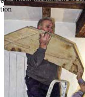
Das Kopfband wird wieder unter die Decke gebracht
