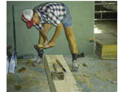
Nach dem Zuschnitt im Sägewerk bearbeitet Wilhelm Möllenbrok den Deckenbalken mit dem Beil
