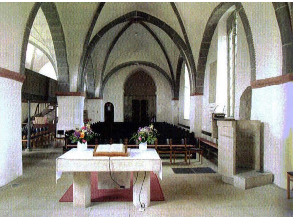
5. Blick aus dem Chorraum in das im Kern romanische Langhaus mit dem gotischen Gewölbe. Die ältesten Bauteile des Langhauses sind der freistehende Pfeiler (Bildmitte li.) und die Nordwand (re.). Im Hintergrund der romanische Bogendurchgang zum Erdgeschoss des angebauten Turms. Links Blick in das Seitenschiff.
