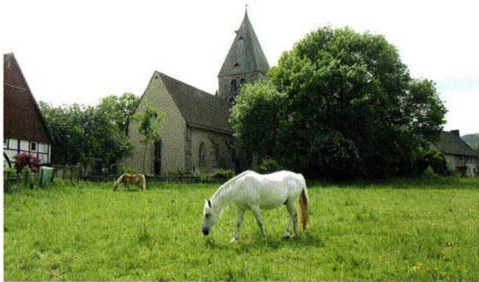
29. Blick von Nordosten auf die Kirche.
